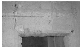
Architrave senza piattabanda. Catena nella fascia di piano
