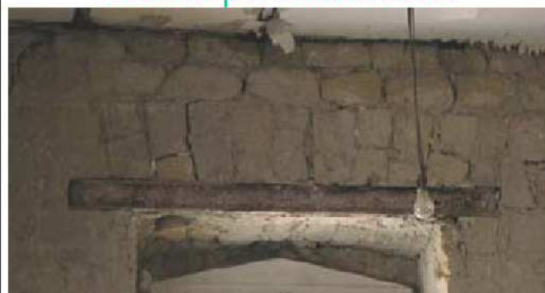
Architrave con piattabanda in acciaio poco ammorsata
