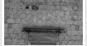
Architrave con piattabanda in acciaio poco ammassata
