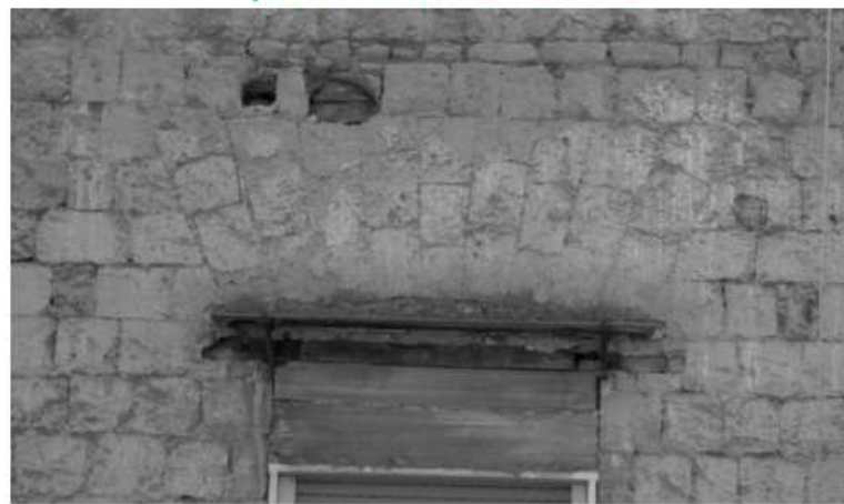
Architrave con piattabanda in legno poco ammorsata
