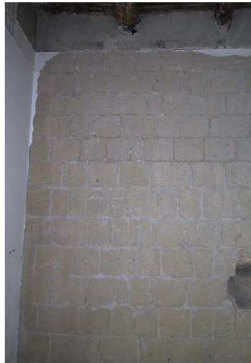
Muratura piena in blocchi di tufo regolari
