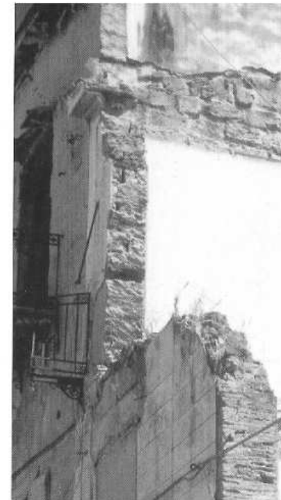
Muratura semiregolare in calcarenite
