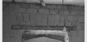
Architrave con piattabanda in acciaio poco ammassata
