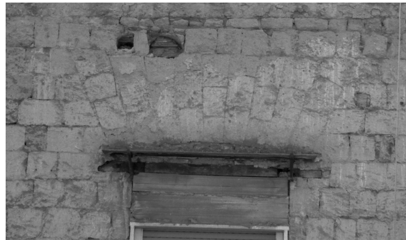
Architrave con piattabanda in legno poco ammorsata
