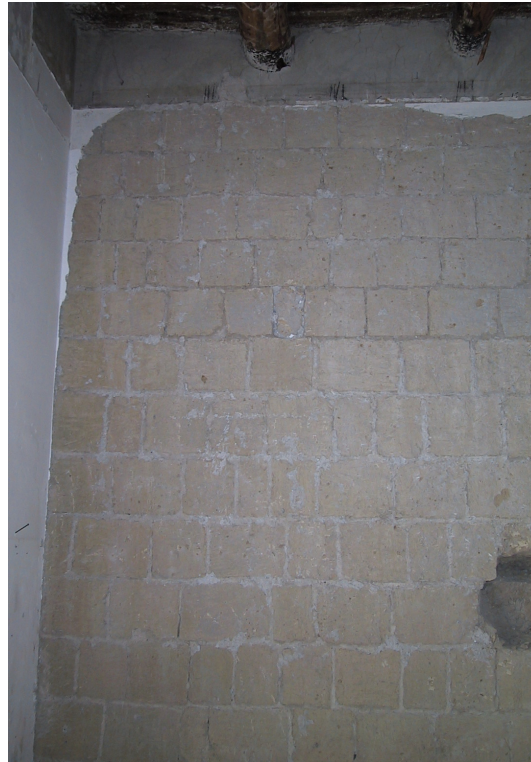
Muratura piena in blocchi di tufo regolari
