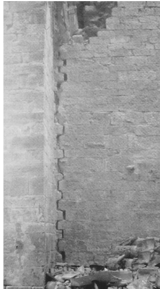
Ripresa di parete muraria con insufficiente ammorsatura
