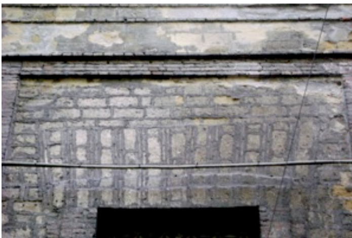
Architrave senza piattabanda ad arco con intradosso piano
