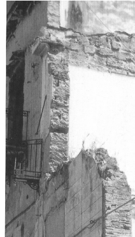
Muratura semiregolare in calcarenite
