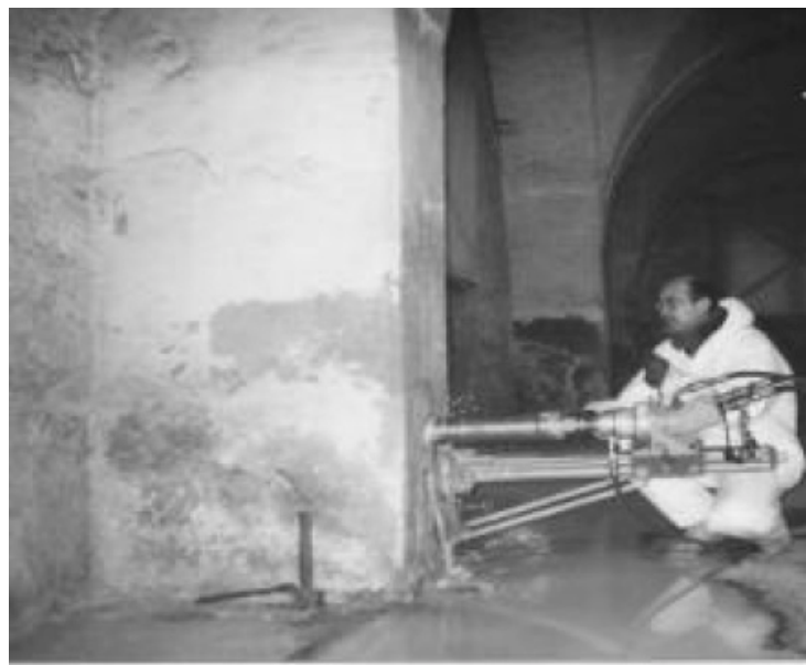
Il carotaggio della muratura
