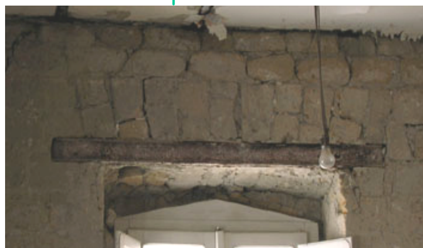
Architrave con piattabanda in acciaio poco ammorsata
