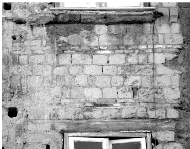
Piattabanda in cemento armato abbastanza ammorsata
