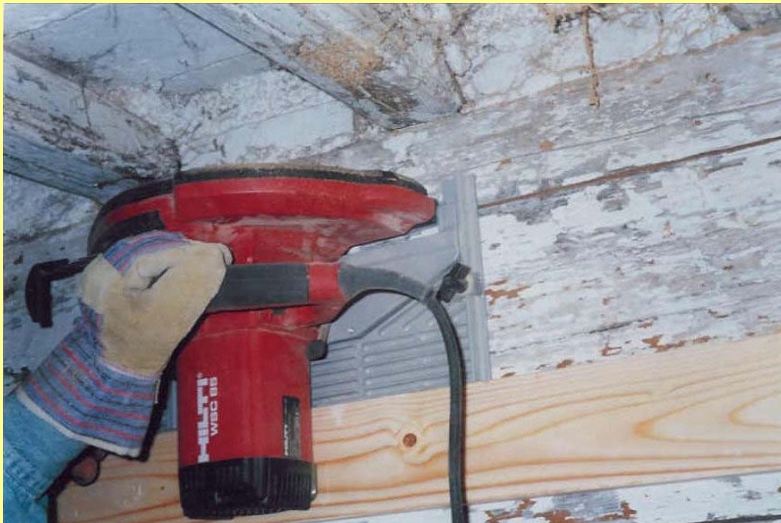
Incisione del legno con fresa a lama sottile
