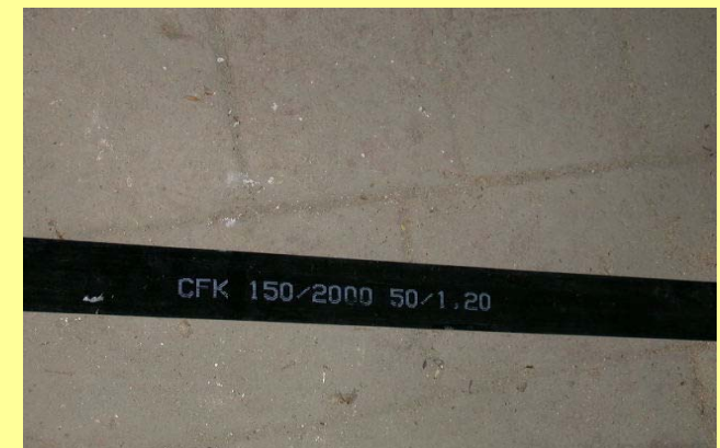
Particolare della lamella in CFRP utilizzata
