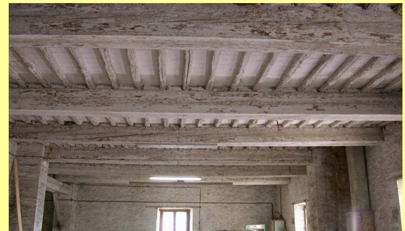
Vista del solaio dall'intradosso
