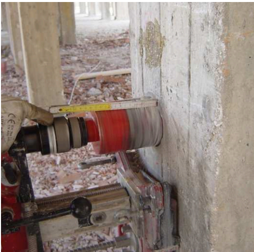
Fasi di estrazione di un campione
