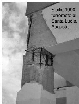
Scorrimento tra la sommità del pilastro e la trave in corrispondenza della ripresa di getto
