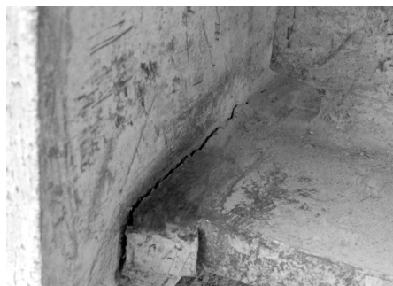
a) frattura lungo la saldatura tra la flangia della trave e della colonna
