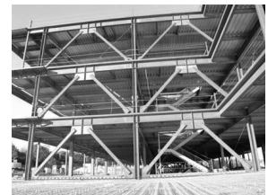
Strutture controventate con controventi concentrici a V invertita (Caso 2)
