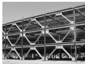
Strutture controventate con controventi concentrici a V a due piani (Caso 2)
