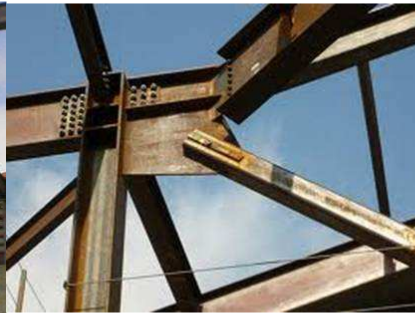
Campata controventata con profili scatolari (Caso 2)
