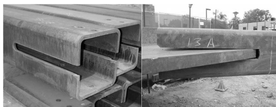
Preparazione dei profili scatolari per il collegamento
