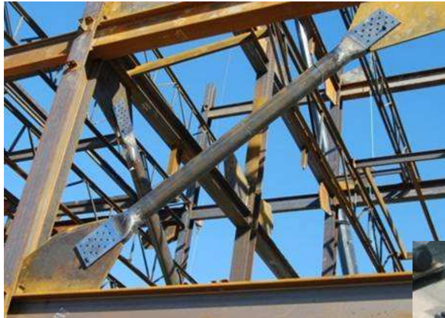
Campata controventata con profili scatolari rotondi (Caso 2)
