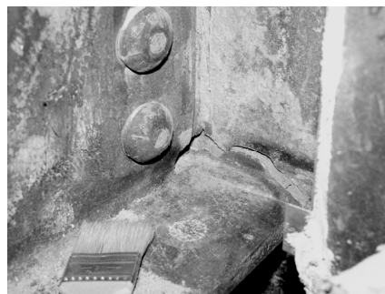
b) frattura lungo la flangia della colonna
