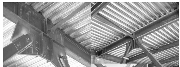
Particolari di collegamento dei controventi concentrici a V alla trave di piano (Caso 2)
