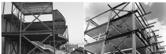
Struttura con controventi concentrici ad X (Caso 1) realizzata con profili scatolari
