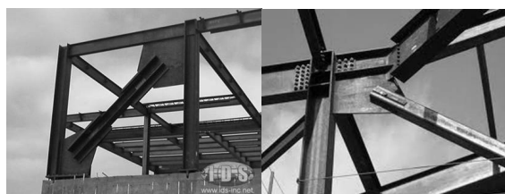
Campata controventata con profili a doppio T (Caso 2)
