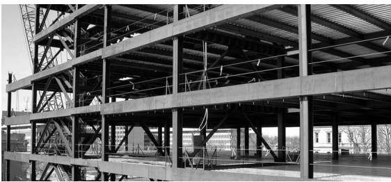
Struttura controventata con controventi concentrici a V invertita (Caso 2)
