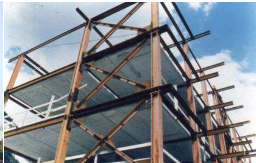
Struttura con controventi concentrici ad X (Caso 1) realizzata con profili angolari
