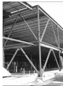
Strutture controventate con controventi concentrici a V invertita (Caso 2)
