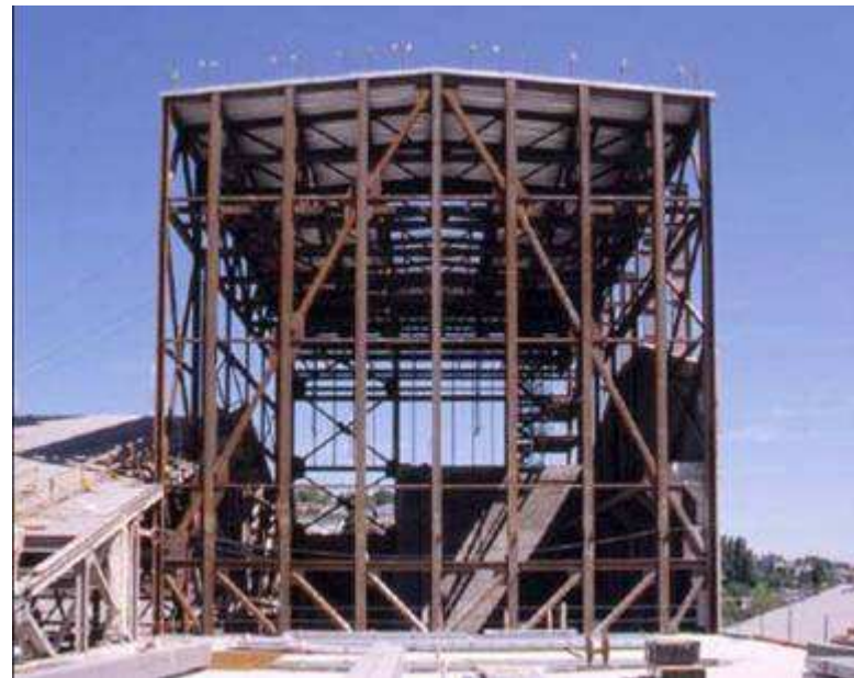
Strutture con controventi concentrici (Caso 2)
