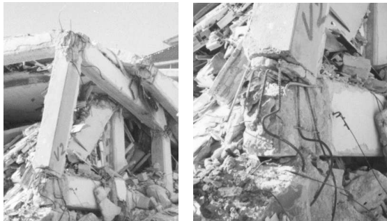
Danneggiamento dei nodi in testa ed al piede del pilastro: non si ha formazione di cerniere plastiche sulla colonna né tantomeno sulle travi
