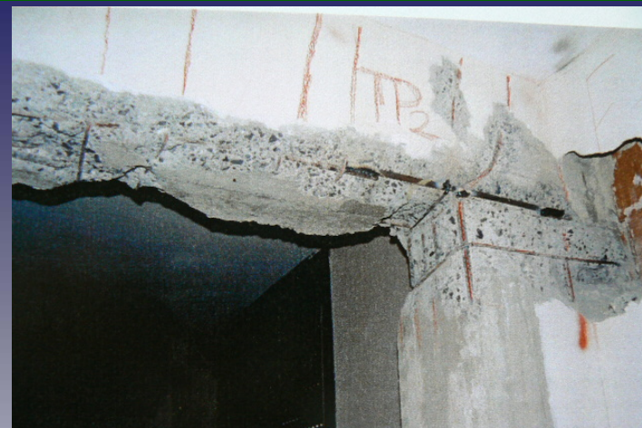
nodo trave-pilastro
