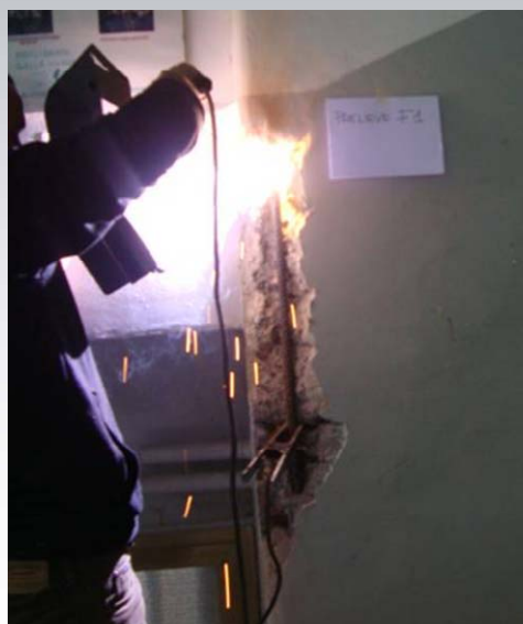
Saldatura barra sostitutiva
