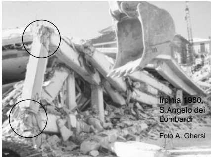
Danneggiamento dei nodi in testa ed al piede del pilastro: non si ha formazione di cerniere plastiche sulla colonna né tantomeno sulle travi
