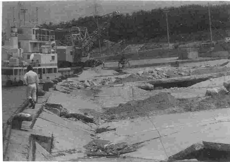
Paratia di pali danneggiata nel porto di Akita (Giappone) nel 1983
