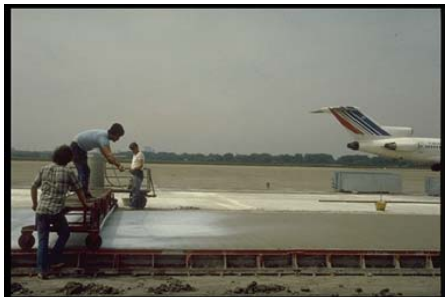
Figura 88 - Applicazione di curing compound.
