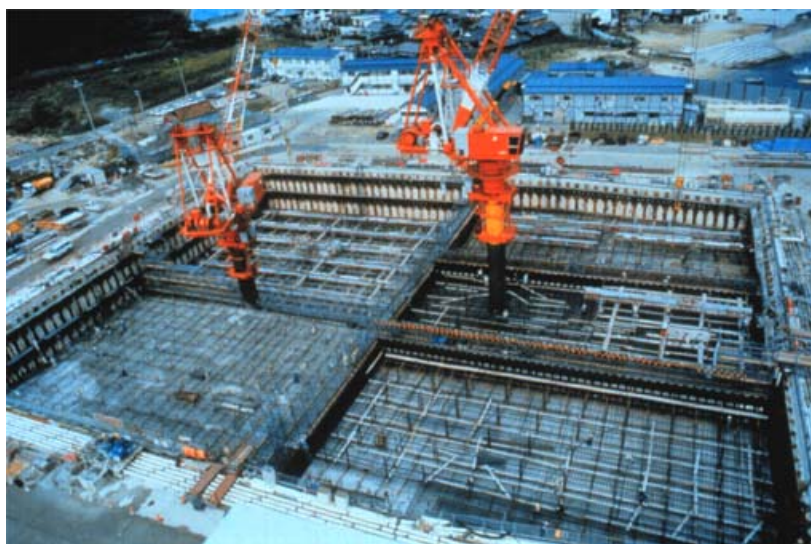
Figura 21 – Messa in opera di calcestruzzo superfluido in strutture fortemente armate (da Archivio ASSIAD).
