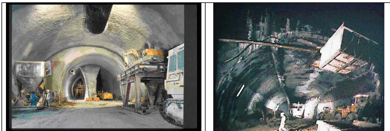
Figura 91 – Tunnel: esempi di scavi a sezione parzializzata (sinistra) ed a tutta sezione (destra).
