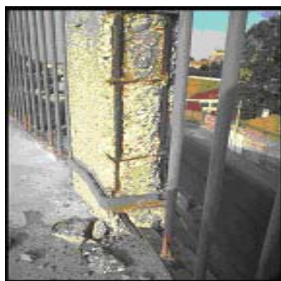
Figura 32 - Ossidazione e corrosione di ferri d'armatura per carbonatazione del calcestruzzo.
