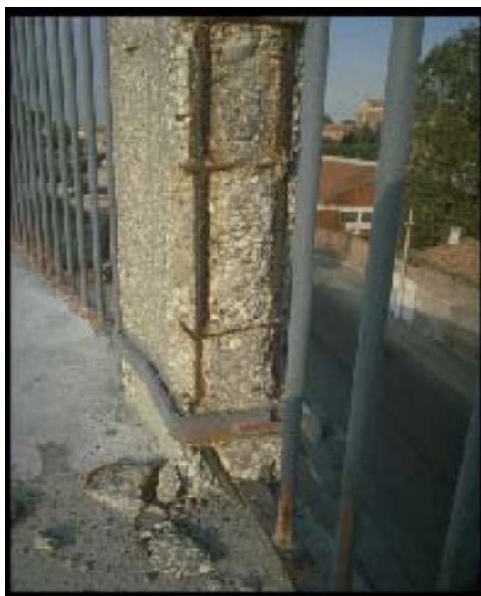
Figura 84 – Corrosione dei ferri d'armatura.
