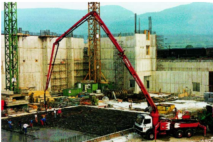
Figura 75 – Pompaggio del calcestruzzo.
