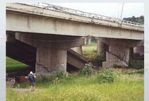
Rottura per taglio
