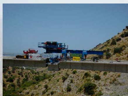
L'IMPALCATO A CASSONE Montaggio con argani
