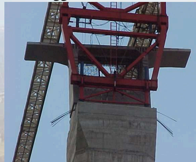
L'IMPALCATO A CASSONE Montaggio con carro di varo
