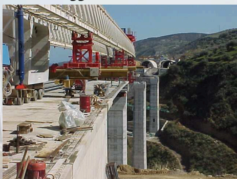
L'IMPALCATO A CASSONE Montaggio con carro di varo
