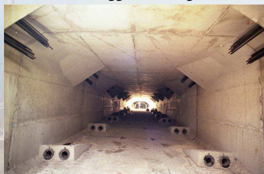
L'IMPALCATO A CASSONE Montaggio con argani
