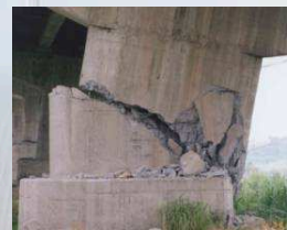
Rottura per taglio
