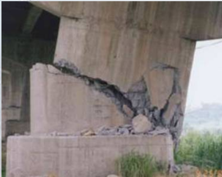
Rottura per taglio
