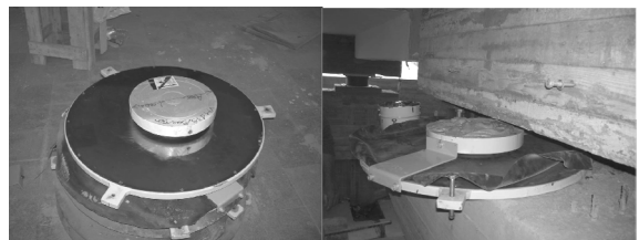
Foto di isolatori a scorrimento a superficie piana
