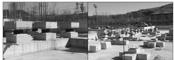
Messa in opera di isolatori elastomerici (scuola di Mazabotto - Bologna)
