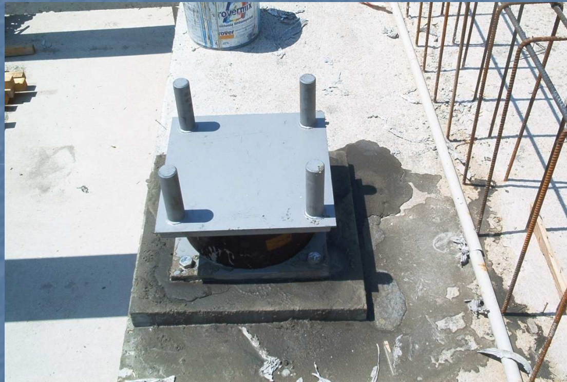
POSIZIONAMENTO DELL'ISOLATORE
