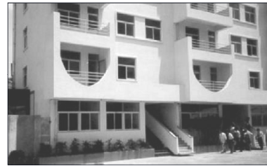
Palazzina residenziale isolata sismicamente con HORB a Shantou nel 1994, prima applicazione cinese di moderni sistemi d'isolamento: si noti la scala d'accesso vincolata alla sovrastruttura ed il gap verticale che essa presenta rispetto al terreno circostante
