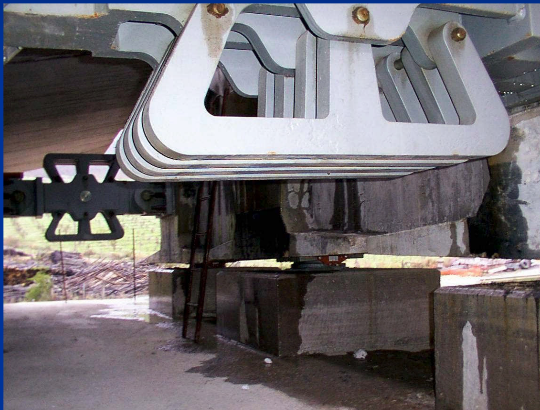
Dissipatore isteretico (tipo E)
