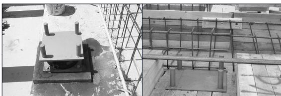
Messa in opera di isolatori elastomerici
