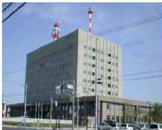
Edificio governativo di 9 piani in c.a. e acciaio con basamento di 1 piano (64 LDRB + 56 LRB + 32 EPD)
