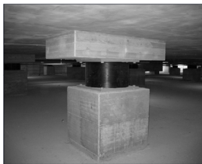
Isolatori elastomerici tra travi di fondazione e travi di elevazione
