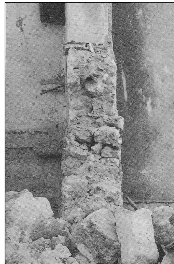
Tipo C2 - mancano i collegamenti trasversali
