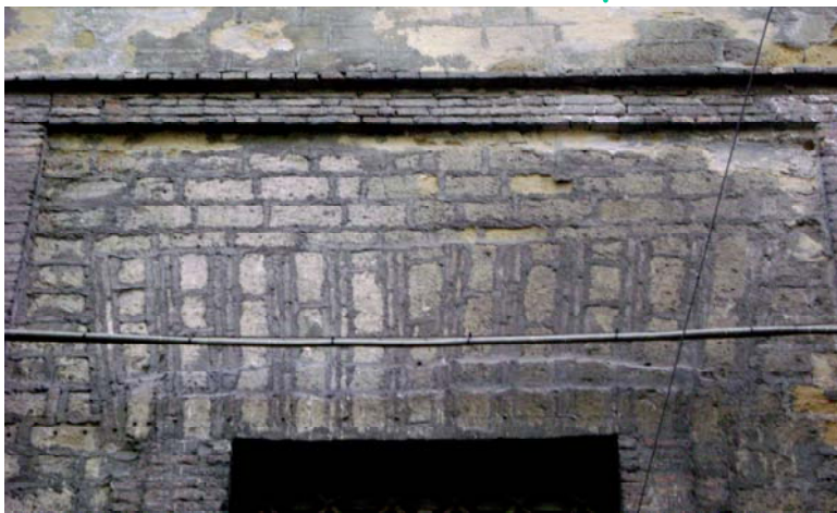
Architrave senza piattabanda ad arco con intradosso piano
