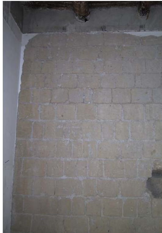
Muratura piena in blocchi di tufo regolari
