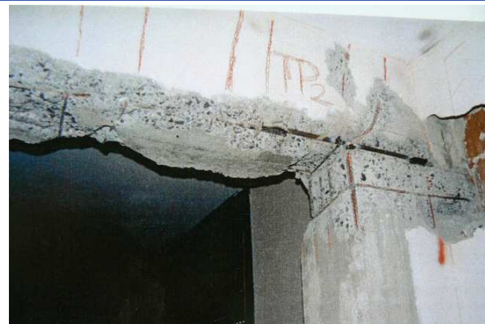
nodo trave-pilastro
