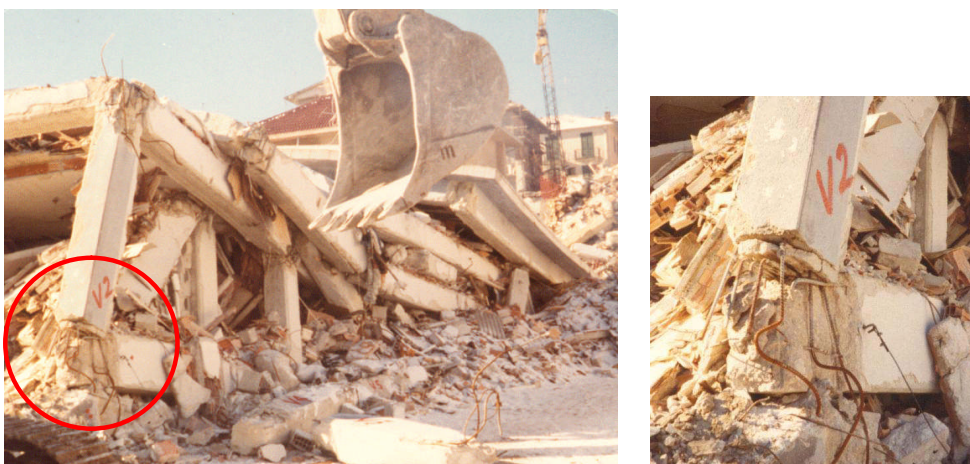
Fig. 3.1: Crollo dovuto a rottura dei nodi (Foto A. Gheresi, Irpinia 1980, Sant'Angelo dei Lombardi)
