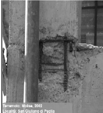
Danneggiamento del nodo trave-colonna esterno: espulsione del copriferro a causa delle sollecitazioni flettenti.
