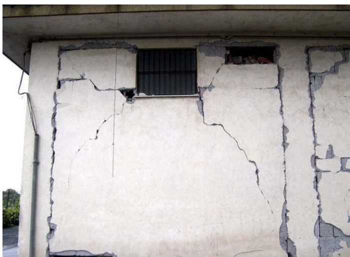
Fig. 1.7. Distacco delle tamponature dagli elementi strutturali (Foto G. Gaeta, Santa Venerina 2002)
