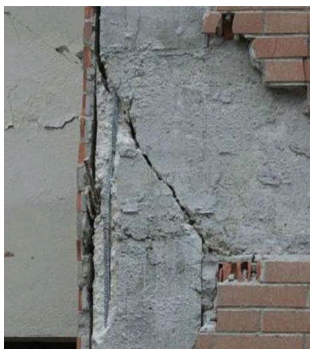
Fig. 3.24: Rottura a taglio del nodo d'angolo con formazione di fessura diagonale e svergolamento della barra longitudinale del pilastro, si evidenzia l'assenza di staffe nel nodo e nell'estremità superiore del pilastro (Foto P. Ricci e G.M. Verderame, Abruzzo 6/4/2009)
