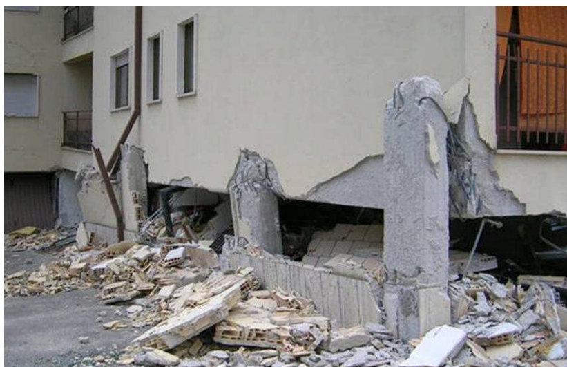
Fig. 1.2. Meccanismo di piano soffice. Particolare del danneggiamento subito dai pilastri del piano terra (Foto P. Ricci e G.M. Verderame, Abruzzo 6/4/2009. Pettino (AQ))
