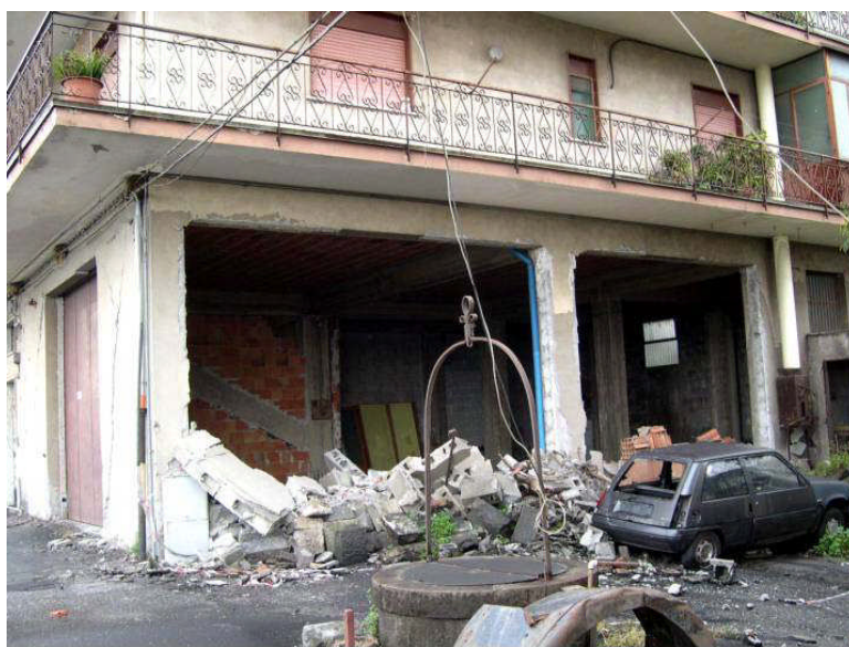
Fig. 1.9. Espulsione delle pareti di tamponamento per azioni ortogonali al loro piano (Foto G. Gaeta, Santa Venerina 2002)
