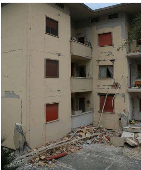
Fig. 1.3. Meccanismo di piano soffice. Il piano terra è scomparso, e la parte in elevazione si è praticamente poggiata sul suolo (Foto P. Ricci e G.M. Verderame, Abruzzo 6/4/2009. Pettino (AQ))
