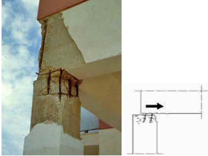
Fig. 3.31: Scorrimento tra la sommità del pilastro e la trave in corrispondenza della ripresa di getto (Sicilia 1990, Augusta)
