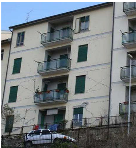
Fig. 1.6. Danneggiamento delle tamponature: sono evidenti le tipiche lesioni diagonali e il distacco dagli elementi strutturali (Foto P. Ricci e G.M. Verdereame, Abruzzo 6/4/2009)
