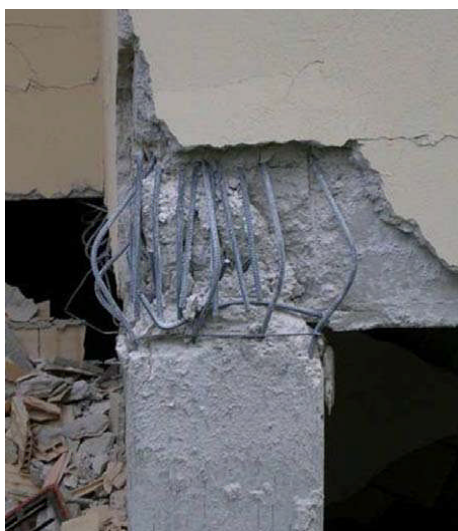
Fig. 3.23: Danneggiamento del nodo d'angolo con svergolamento delle barre longitudinali del pilastro ed espulsione del copriferro, si evidenzia la mancanza di staffe (Foto P. Ricci e G.M. Verderame, Abruzzo 6/4/2009)
