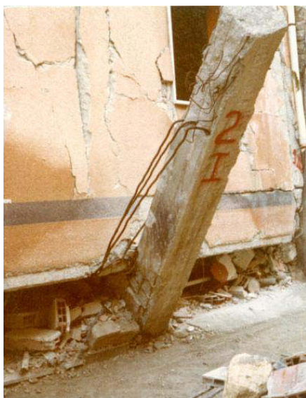
Fig. 3.2: Scorrimento tra la sommità del pilastro e la trave in corrispondenza della ripresa di getto con sfilamento delle barre (Foto A. Gheresi, Irpinia 1980, Lioni, Edificio del Banco di Napoli)
