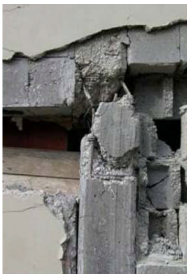
Fig. 3.26: Collasso del nodo trave- pilastro perimetrale esterno, rottura causata dalle elevate sollecitazioni da taglio (Molise 2002, San Giuliano di Puglia)
