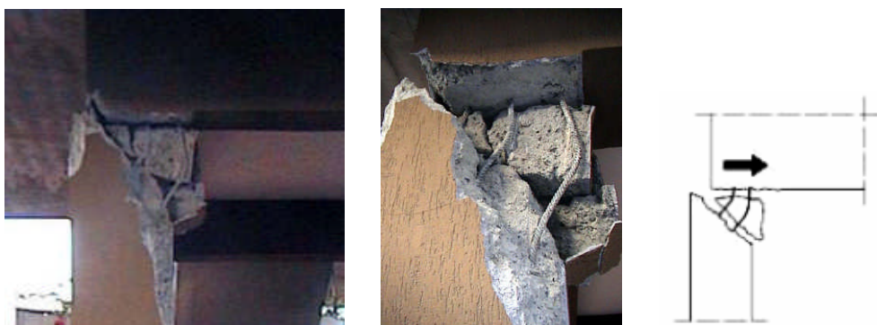
Fig. 3.3: Espulsione di blocchi di calcestruzzo e scorrimento lungo la lesione (Foto G. Gaeta, Santa Venerina 2002)
