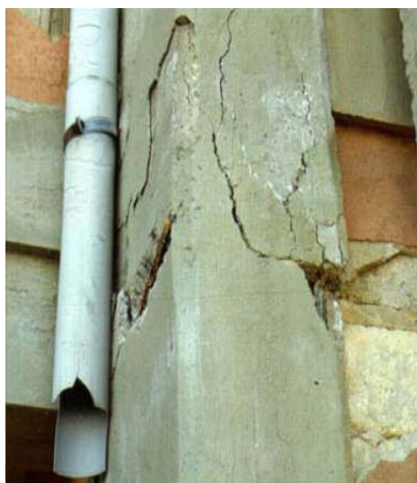
Fig. 3.25: Danneggiamento del nodo trave-pilastro a causa degli elevati sforzi assiali e di taglio (Sicilia 1990, Augusta)
