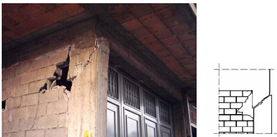
Fig. 3.4: Rottura diagonale della muratura e propagazione come lesione a taglio del pilastro (Foto G. Gaeta, Santa Venerina 2002)
