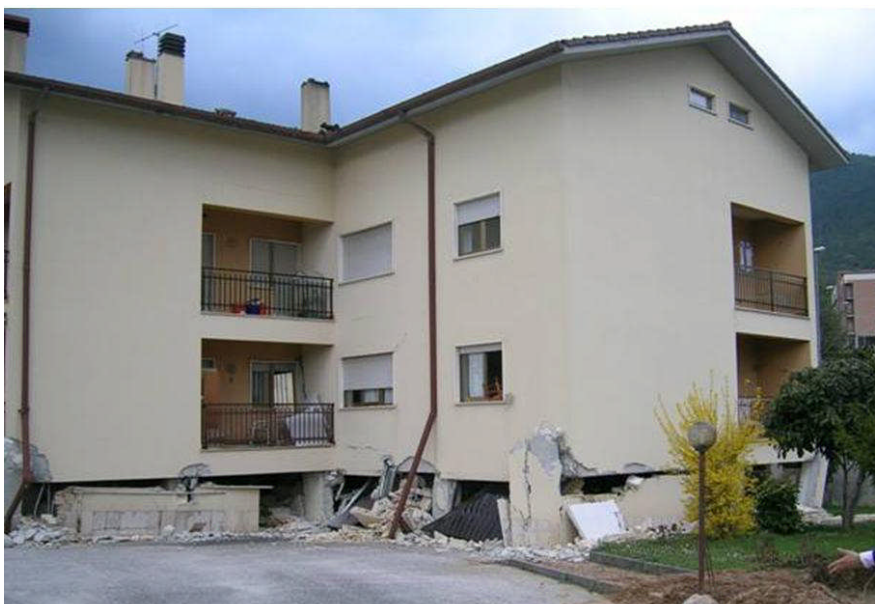
Fig. 1.1. Meccanismo di piano soffice. (Foto P. Ricci e G.M. Verderame, Abruzzo 6/4/2009. Pettino (AQ)).
