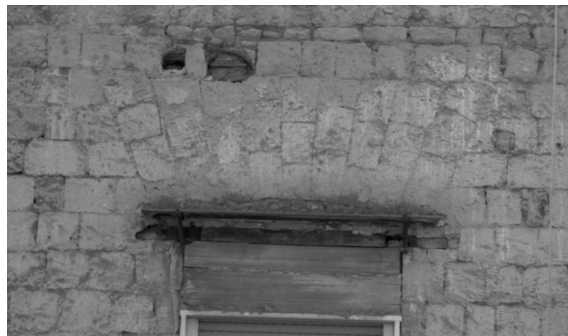
Architrave con piattabanda in legno poco ammorsata
