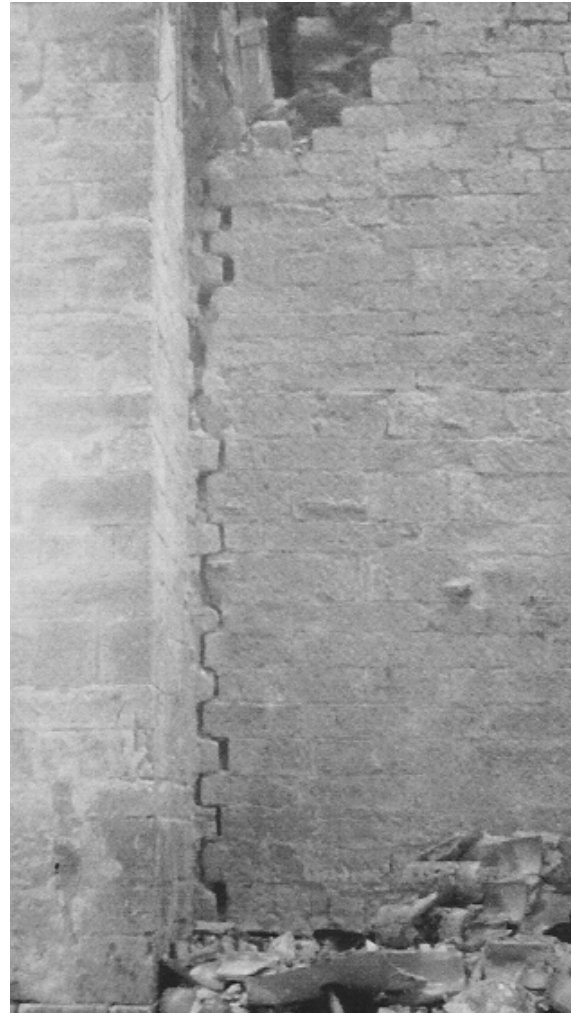
Ripresa di parete muraria con insufficiente ammorsatura
