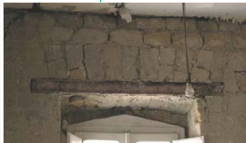
Architrave con piattabanda in acciaio poco ammorsata
