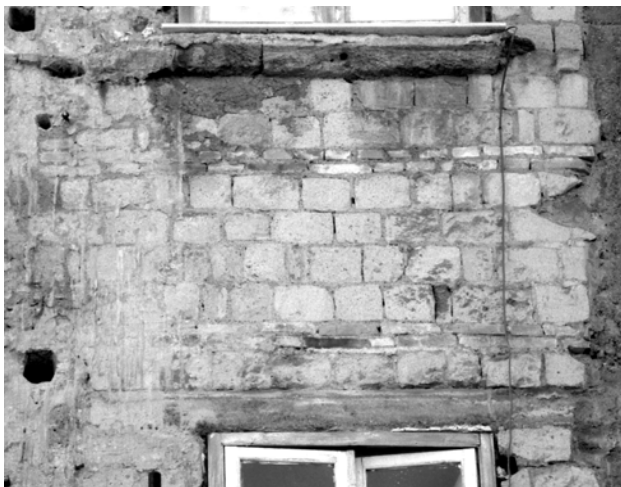
Piattabanda in cemento armato abbastanza ammorsata
