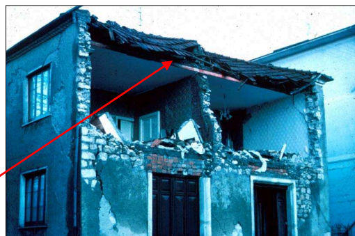
Le pareti di facciata si ribaltano verso l'esterno e portano al crollo rovinoso parziale o totale
