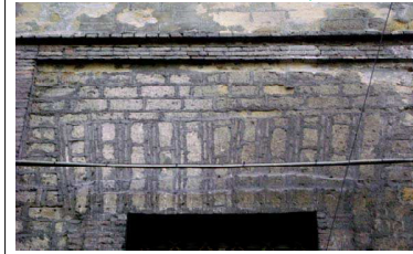
Piattabanda in cemento armato abbastanza ammassata
