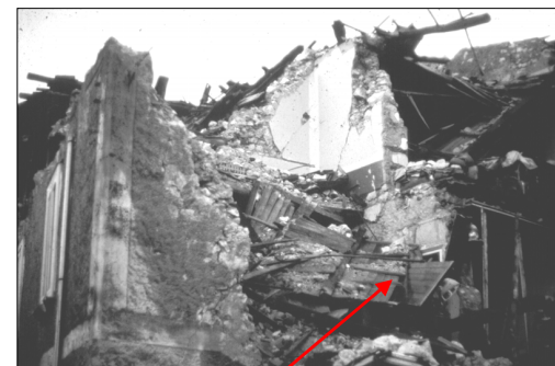
Le pareti di facciata si ribaltano verso l'esterno e portano al crollo rovinoso parziale o totale
