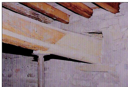
Risanamento con sostituzione della parte marcita con protesi lignea incollata con barre di acciaio
