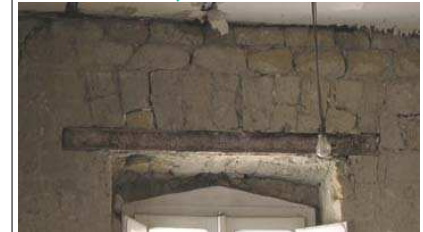
Architrave con piattabanda in acciaio poco ammassata
