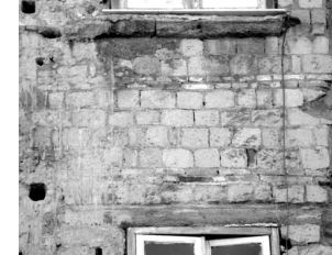
Piattabanda in cemento armato abbastanza ammassata
