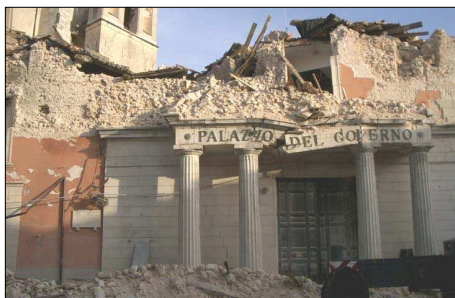
La scadente qualità della muratura di pietrame, caotica e mal legata, non ha consentito un comportamento monolitico dei muri
