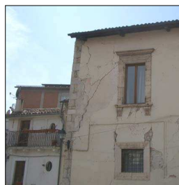
In città non abbiamo rilevato nessun caso evidente di crollo parziale delle pareti (nelle zone alte triangolari) riconducibile al comportamento nel piano
