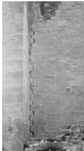
Ripresa di parete muraria con insufficiente ammorsatura
