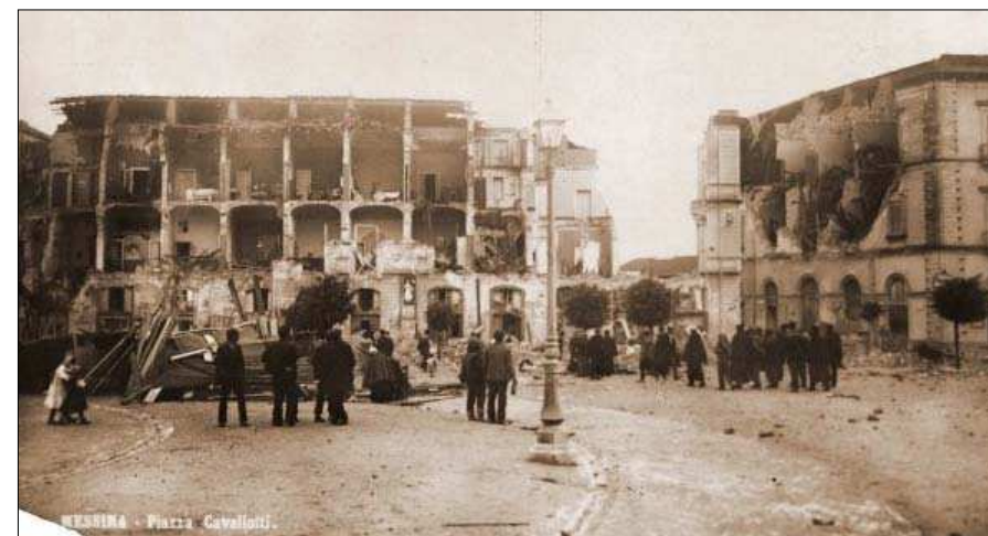
Si sono distaccati prevalentemente i muri perimetrali non "portanti" con conseguenti crolli parziali o globali per meccanismi fuori dal piano
