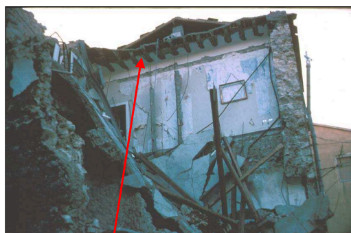
Le pareti di facciata si ribaltano verso l'esterno e portano al crollo rovinoso parziale o totale
