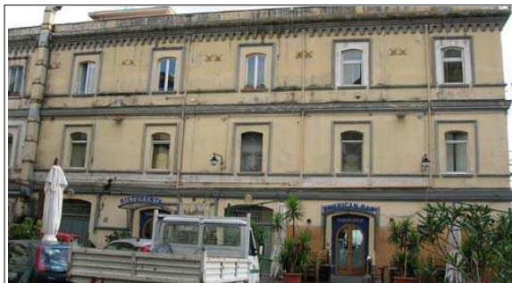
Dettaglio di una catena adiacente ad un muro di spina
