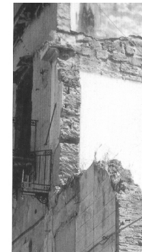
Muratura semiregolare in calcarenite
