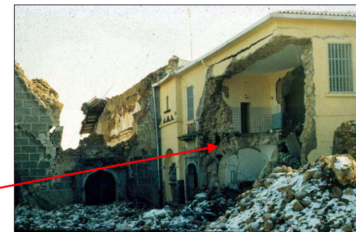
Le pareti di facciata si ribaltano verso l'esterno e portano al crollo rovinoso parziale o totale
