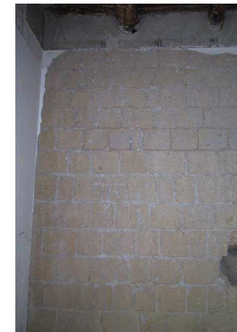
Muratura piena in blocchi di tufo regolari
