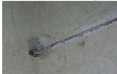
Dettaglio di una catena adiacente ad un muro di spina
