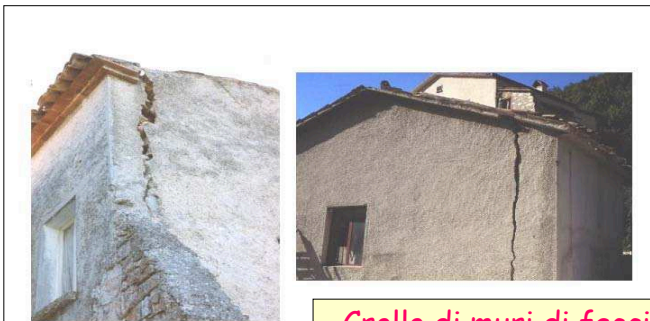
Crollo di muri di facciata per insufficiente ammassamento
