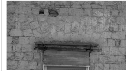
Architrave con piattabanda in acciaio poco ammassata
