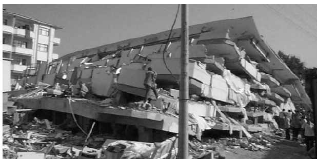
Crollo totale - tipico (pilastri scadenti)
