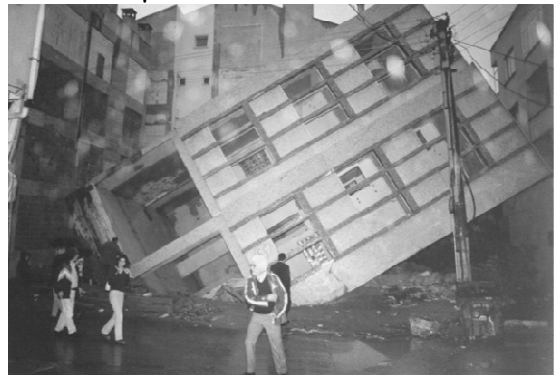
Liquefazione del terreno
