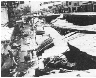
Liquefazione di strati sotterranei
