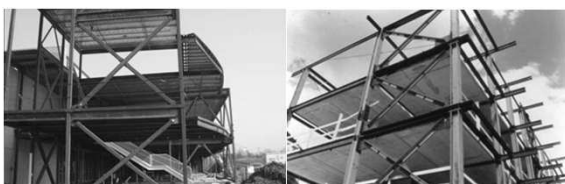
Struttura con controventi concentrici ad X (Caso 1) realizzata con profili scatolari
