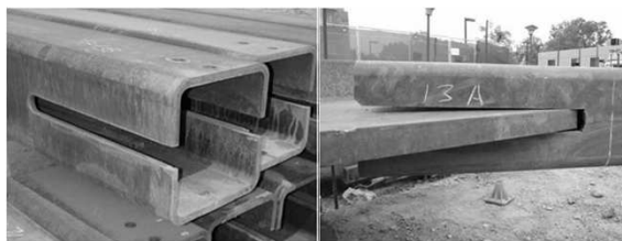
Preparazione dei profili scatolari per il collegamento
