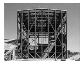
Strutture con controventi concentrici (Caso 2)
