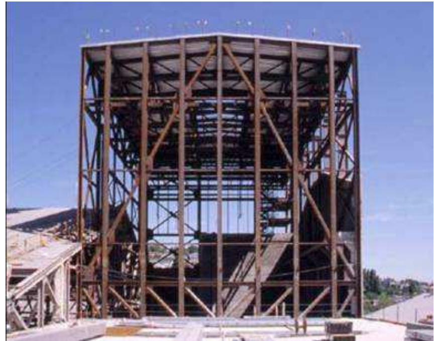
Strutture con controventi concentrici (Caso 2)
