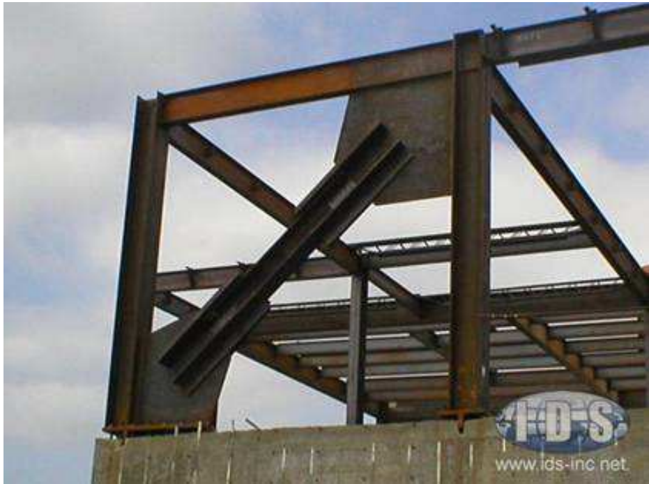
Campata controventata con profili a doppio T (Caso 2)
