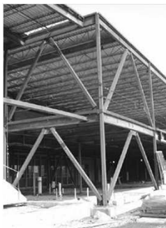
Strutture controventata con controventi concentrici a V invertita (Caso 2)
