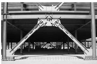
Progetto del collegamento dei controventi
