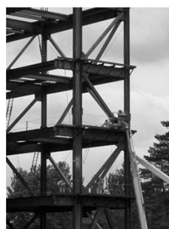
Strutture con controventi concentrici (Caso 2)
