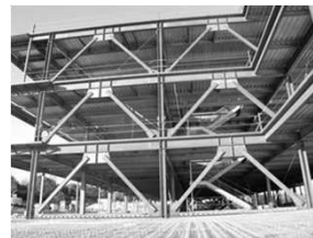
Strutture controventata con controventi concentrici a V invertita (Caso 2)
