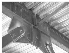
Particolari di collegamento dei controventi concentrici a V alla trave di piano (Caso 2)
