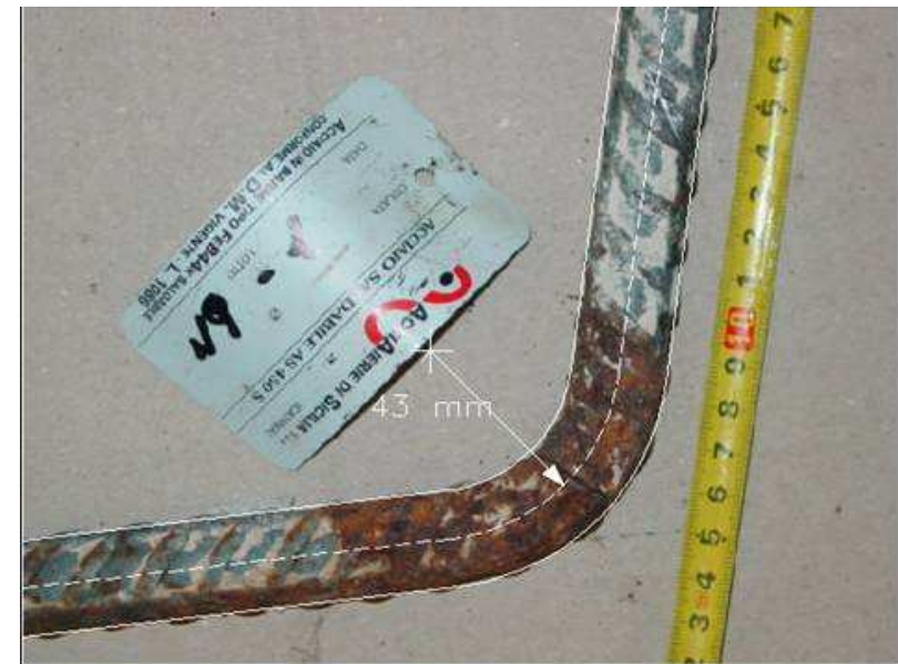
Rilievo dei raggi di curvatura
