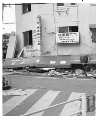
Perdita del piano inferiore
