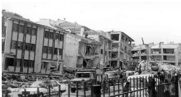
Perdita del piano inferiore - altri esempi
