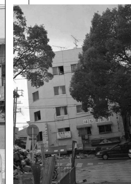
Perdita del piano inferiore
