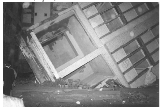
Liquefazione del terreno
