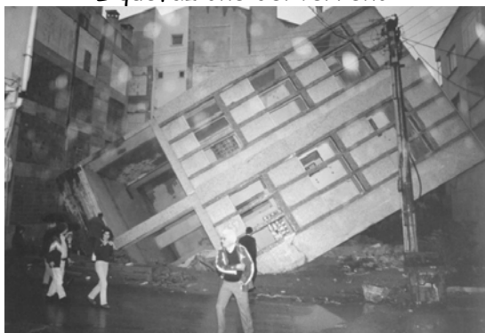
Liquefazione del terreno
