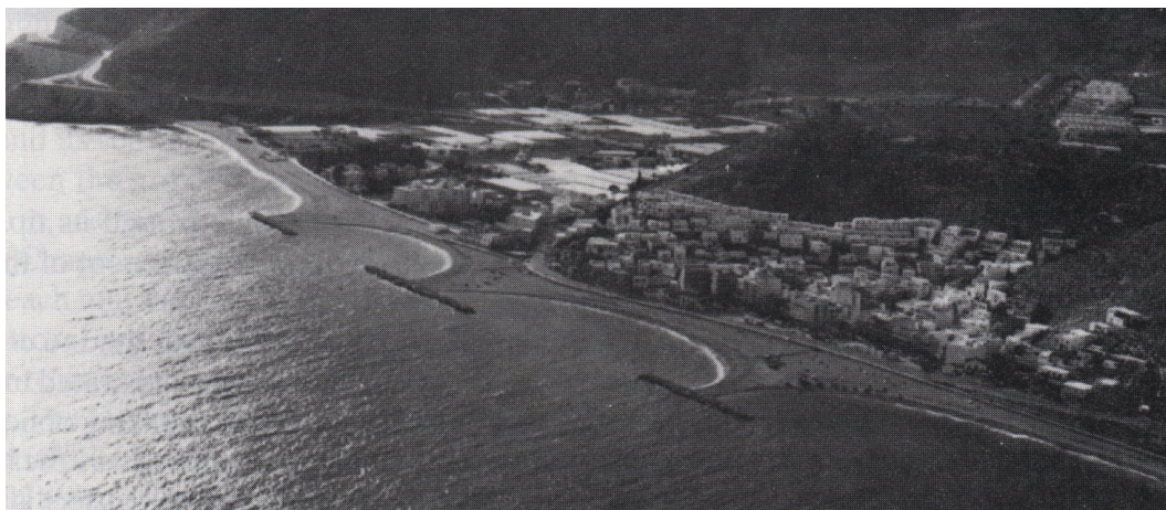
Figura 16.4. Esempio di realizzazione di barriere emerse distaccate.
