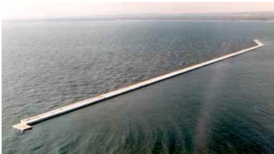
Figura X.4. Immagine aerea dell'antemurale del porto industriale di Taranto. La diga è lunga 1300 m ed è formata con 58 cassoni cellulari fondati su scanno formato previa escavazione del fondale argilloso e spandimento di sabbia.
