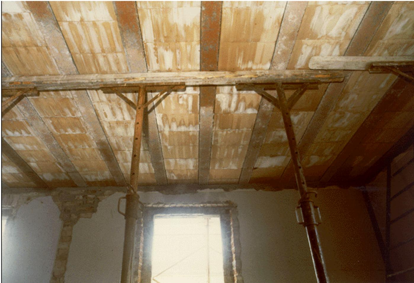
Supporti provvisori di solaio con travetti prefabbricati
