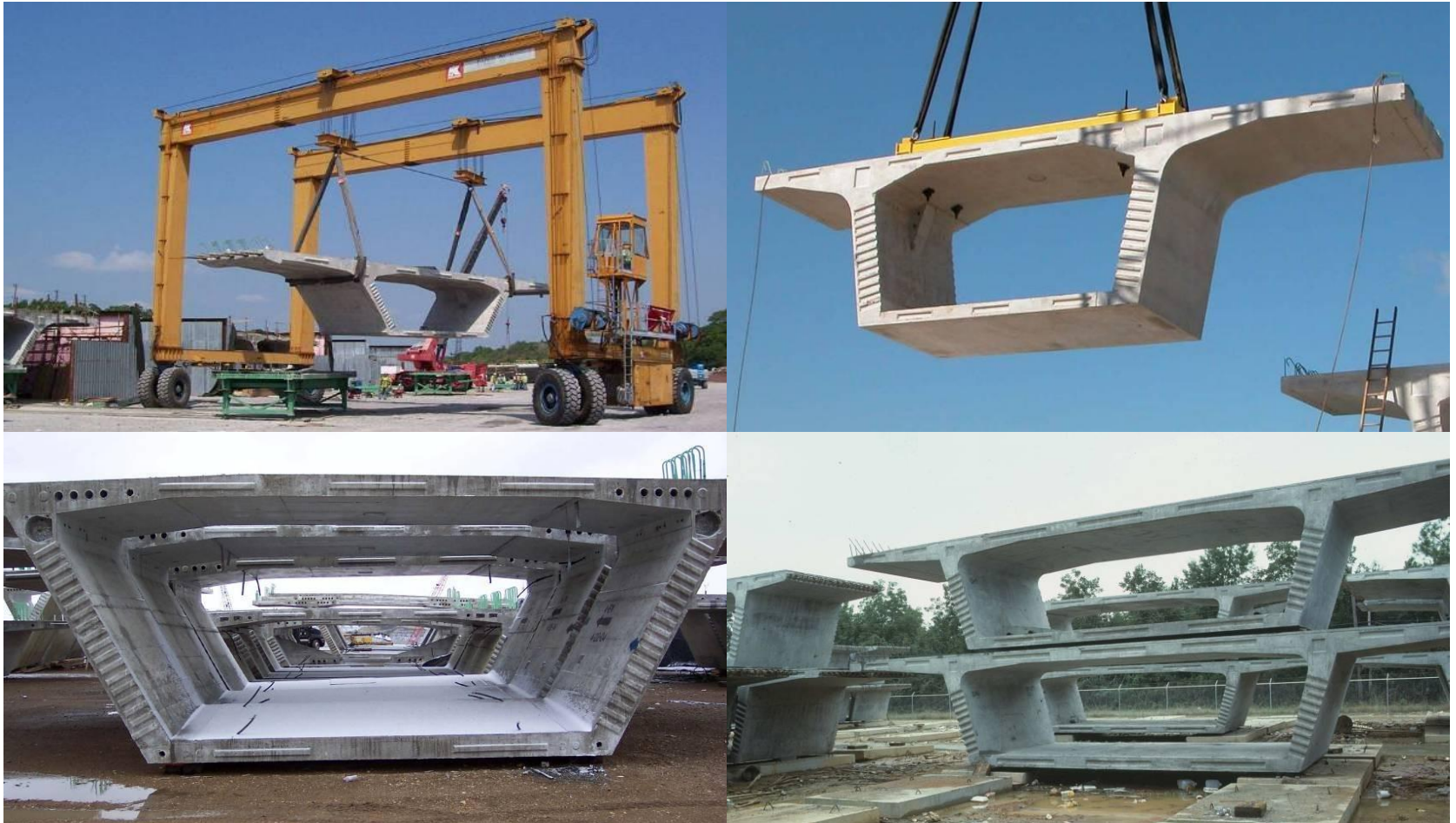
Movimentazione e stoccaggio dei conci
