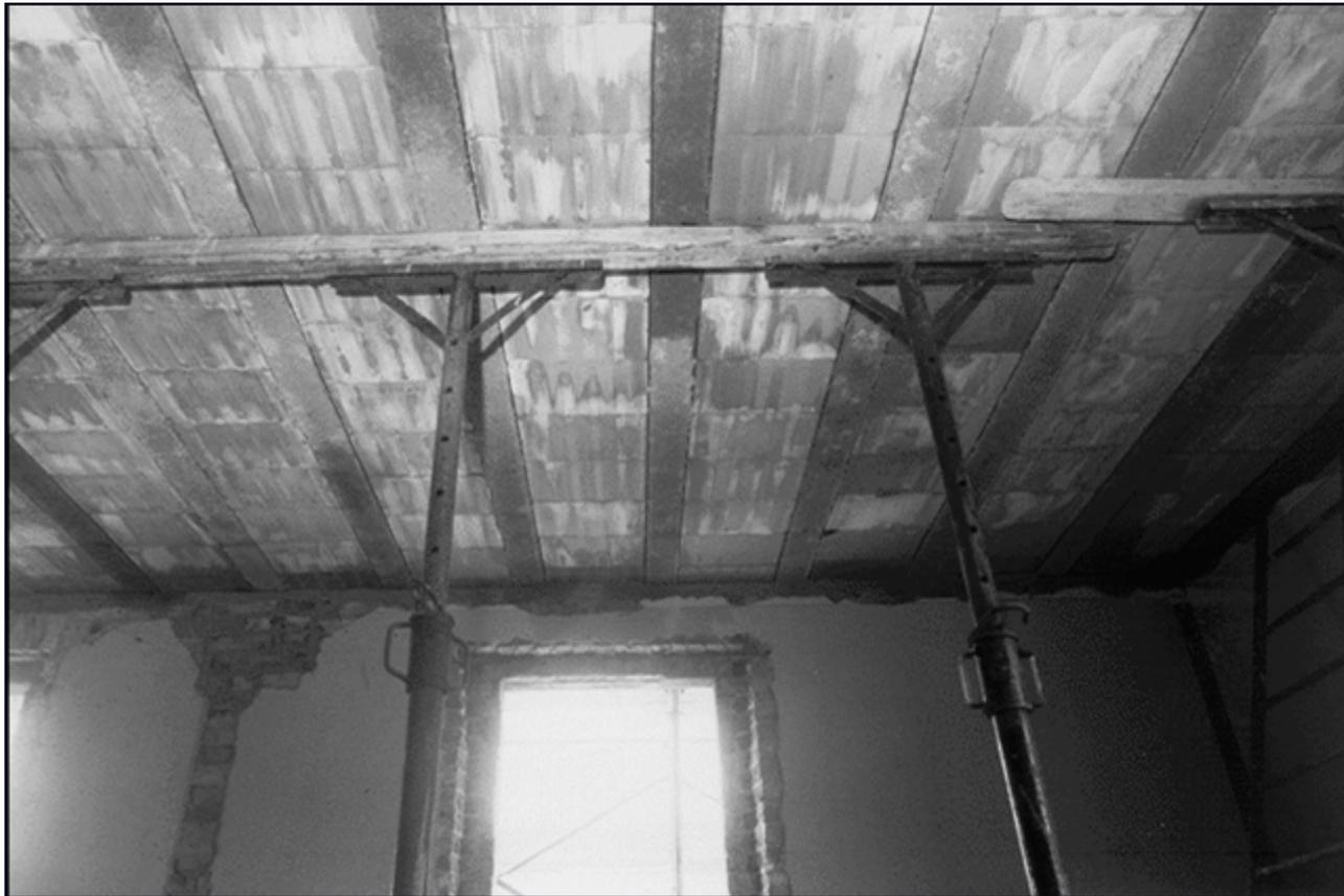
Supporti provvisori di solaio con travetti prefabbricati
