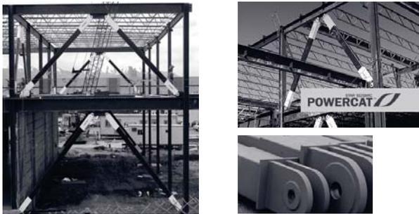
Struttura con controventi ad instabilità impedita nella tipologia a V invertita e collegamenti incernierati
