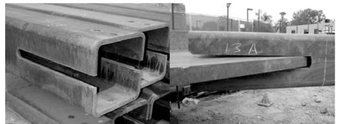
Preparazione dei profili scatolari per il collegamento
