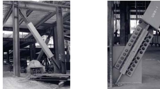
Struttura con controventi ad instabilità impedita con collegamenti non incernierati
