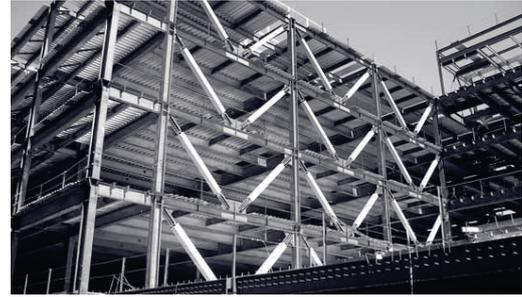
Struttura con controventi ad instabilità impedita nella tipologia a V
