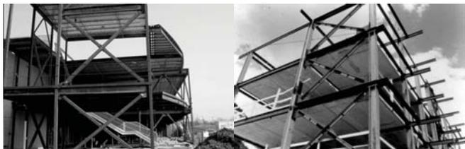
Struttura con controventi concentrici ad X realizzata con profili scatolari (Caso 1)
