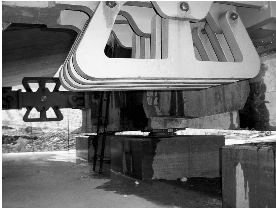
Dissipatore isteretico (tipo E)
