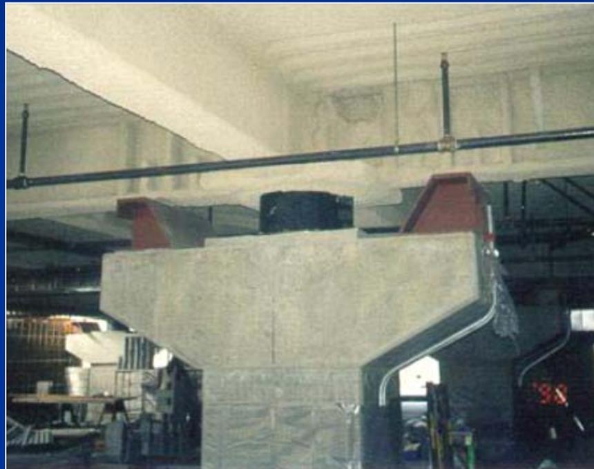
Dispositivi alternativi per il trasferimento dei carichi verticali alla sottostruttura
