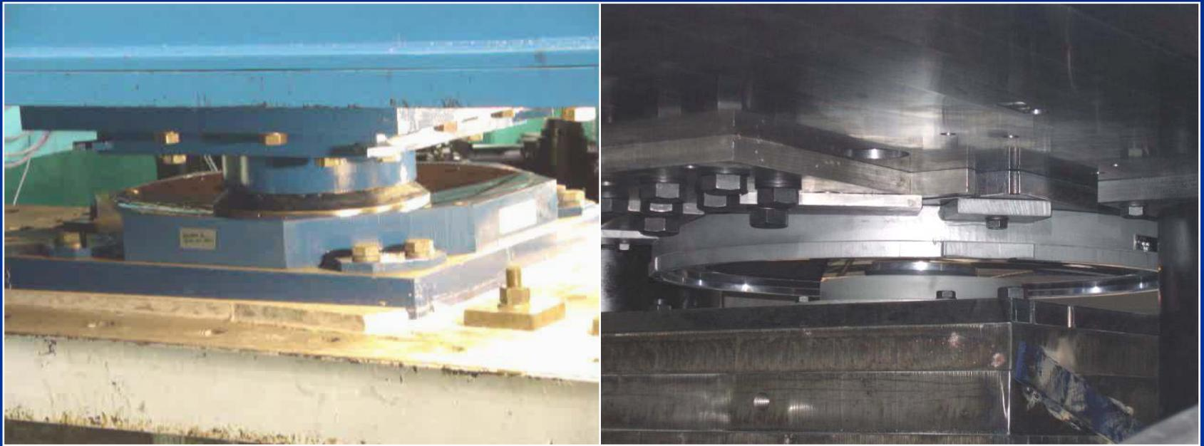
Foto di isolatori a scorrimento a superficie curva semplice
