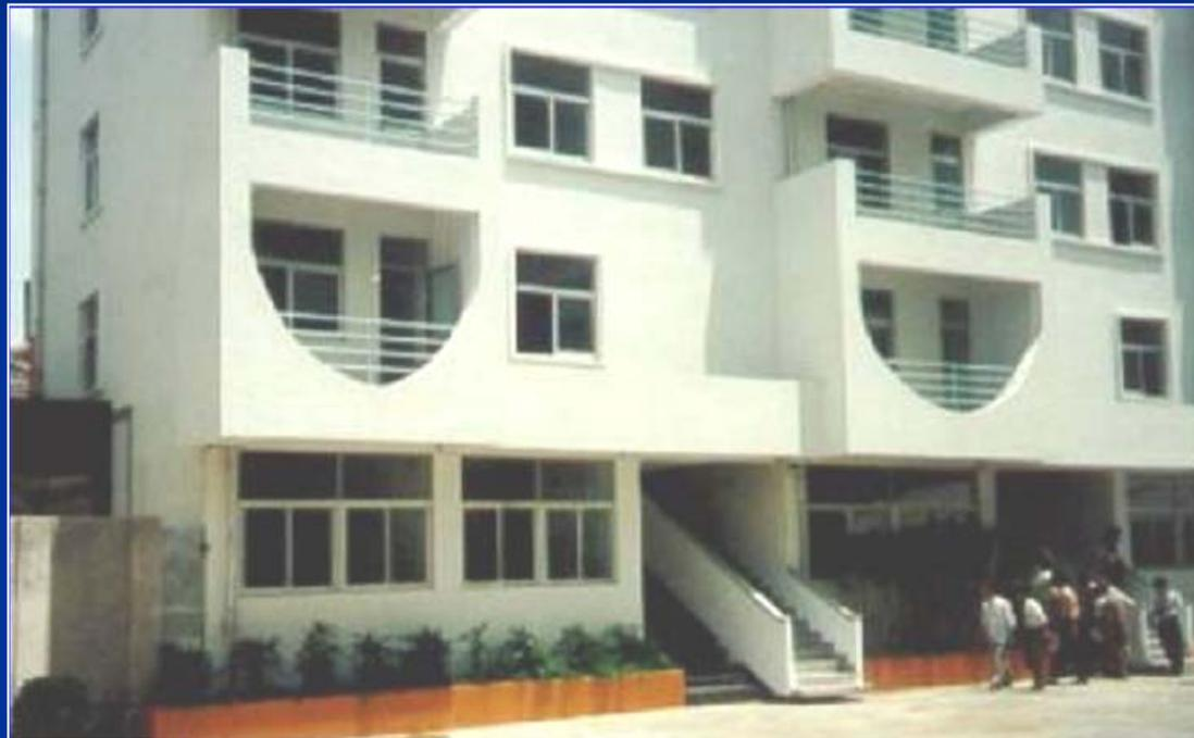
Palazzina residenziale isolata sismicamente con HDRB a Shantou nel 1994, prima applicazione cinese di moderni sistemi d'isolamento: si noti la scala d'accesso vincolata alla sovrastruttura ed il gap verticale che essa presenta rispetto al terreno circostante
