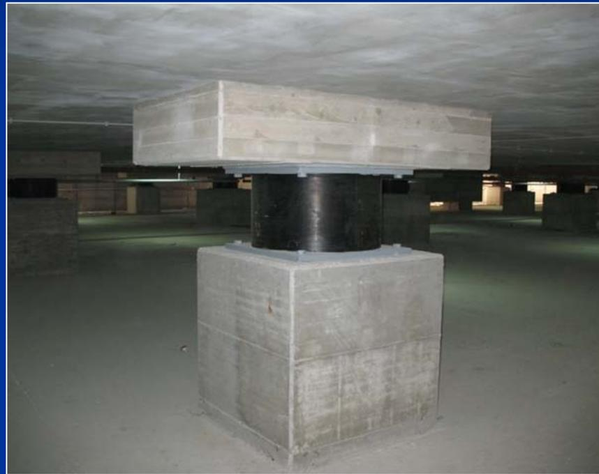
Isolatori elastomerici tra travi di fondazione e travi di elevazione
